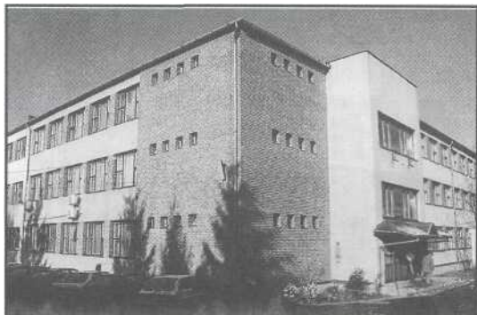
Az iskola központi épülete. A könyvtárterem a bejárástól közel található
