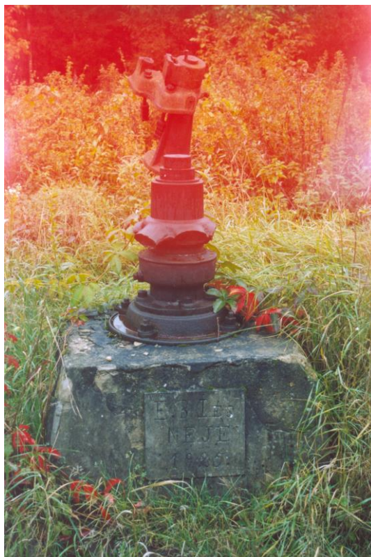
849. A malom turbinatengelyének csonkjja. A beton alapon lévő betűk: É.[pitette] B.[aumgartner] L.[ajos] és NEJE 1925. Fotó: Marx Mária.
