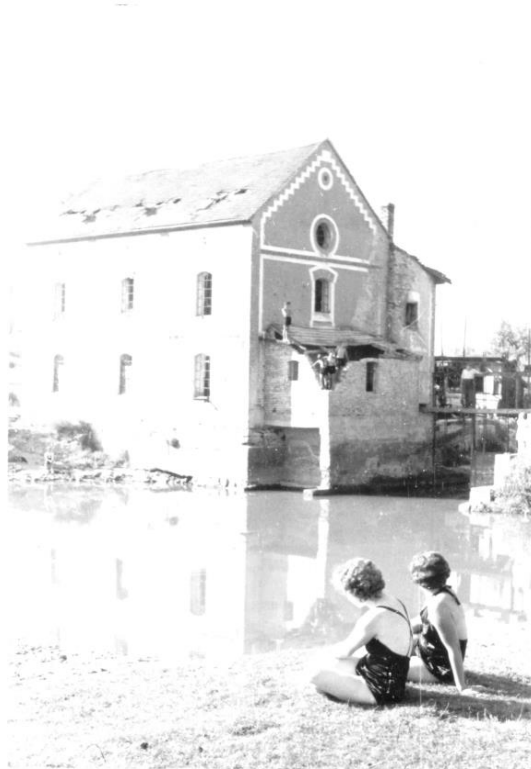
Zalakoppány, Mittel-malom (Mittermayer)
