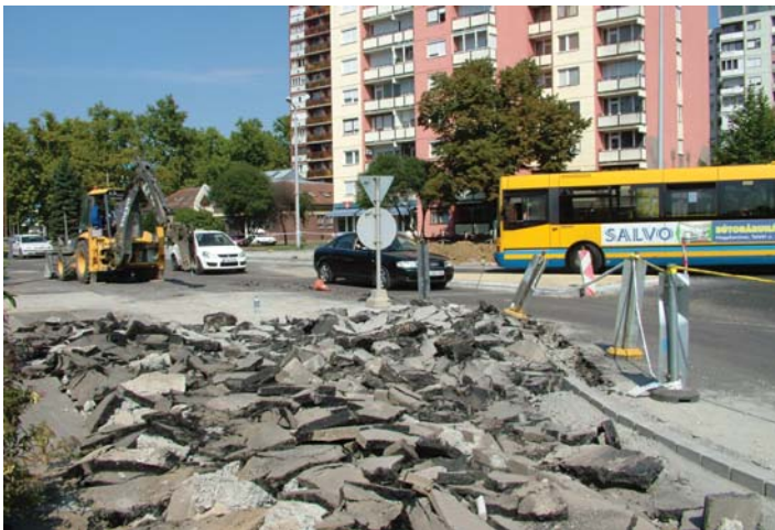
Gépjárművek közlekedése mellett épül a Teleki u. - Kórház u - Zrínyi u. körforgalom
