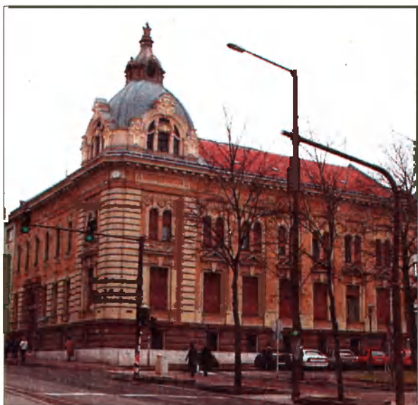
Az Osztrák-Magyar Bank 1901-ben elhatározta, hogy a Nagykanizsai Fiókja részére palotát fog építeni. A látható épület 1903-ban kezdte meg áldásos tevékenységét.
